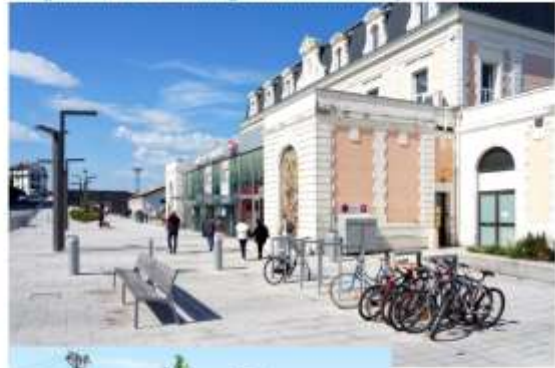
Inauguration – Pôle d'échanges multimodal de Bayonne - 2021
