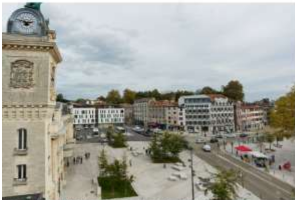
Inauguration – Pôle d'échanges multimodal de Bayonne - 2022
